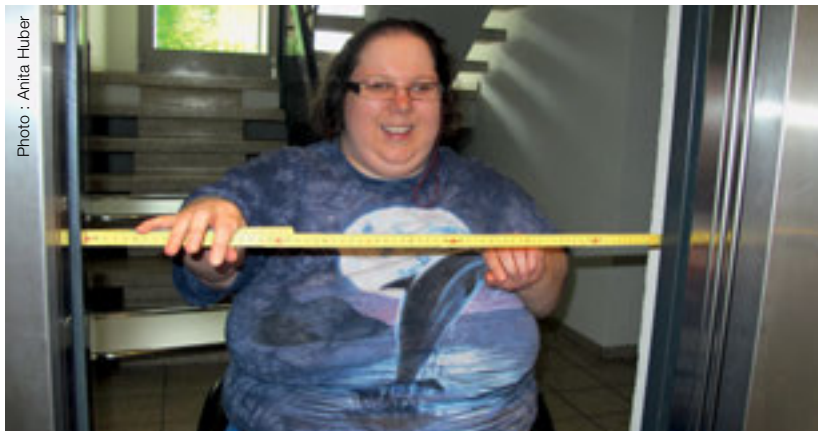
L'ascenseur de l'immeuble ne satisfait pas aux exigences minimales.
